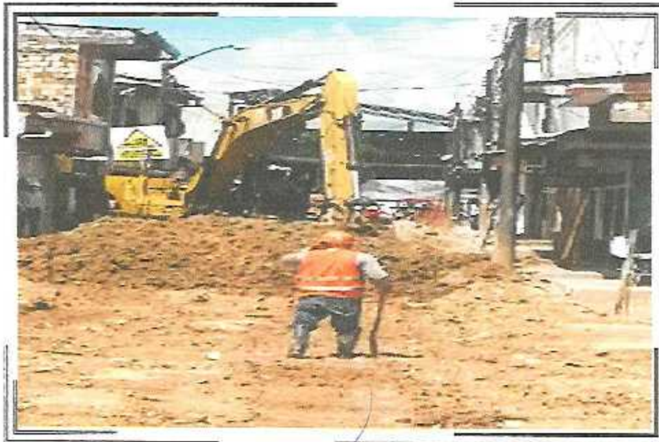
EXCAVACION O MOVIMIENTO DE TIERRA EN LA PSJ. GONZALES VIGIL
