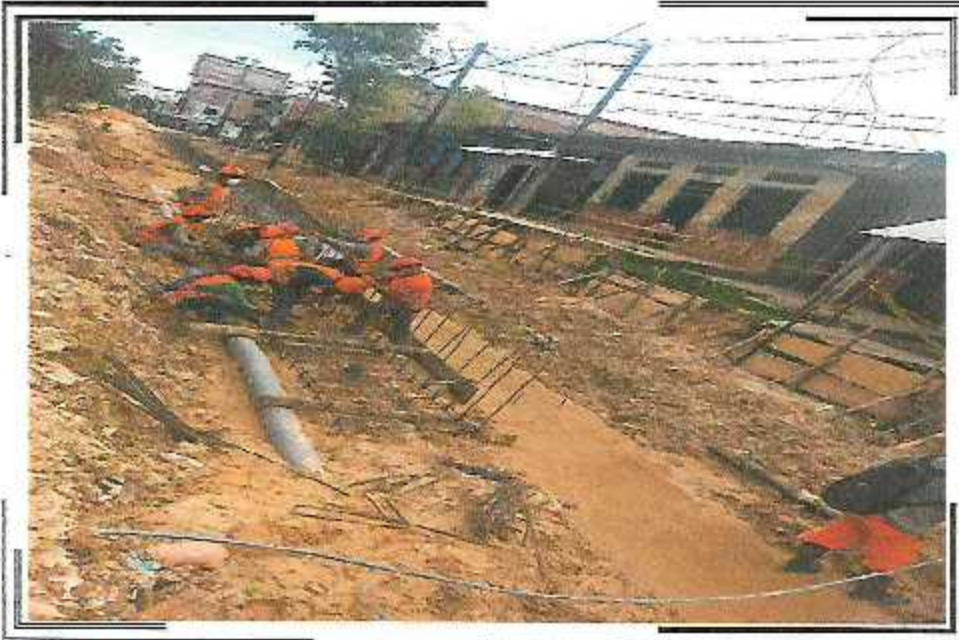
COLOCACION DE ACERO EN EL TRAMO DE PSJ. QUIÑONES ENTRE CA. DOS DE MAYO Y PSJ. MIAMI
