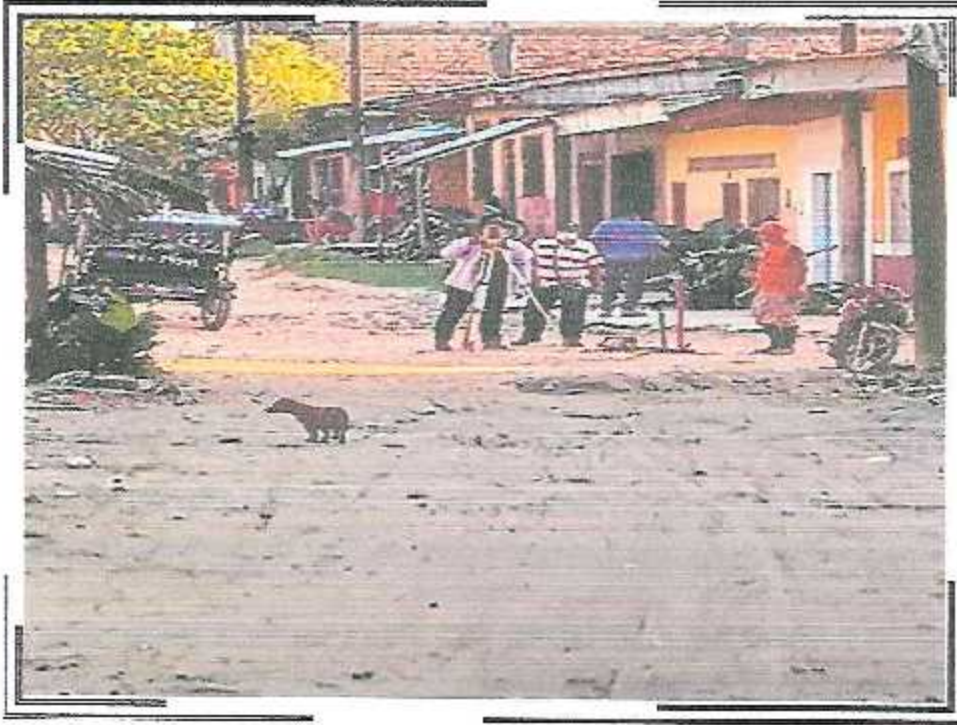
TRAZO Y REPLANTEO DE CALLE A INTERVENIR
