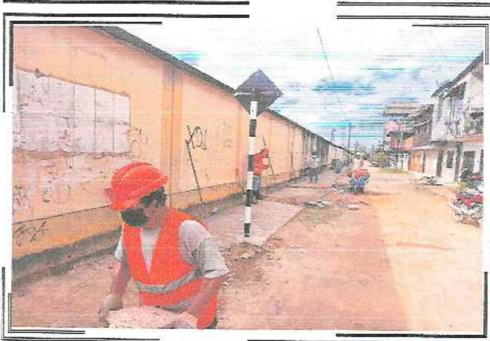
DEMOLICION DE VEREDAS EXISTENTE TRAMO CA. QUIÑONES ENTRE AV. MARISACAL CACERES / PSJ. MIAMI
