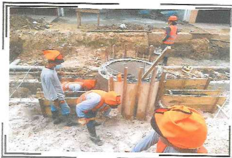
DESENCUFRADO DE BUZON DE LA PROGRESIVA 0+075 DEL PSJ. QUIÑONES TRAMO III
