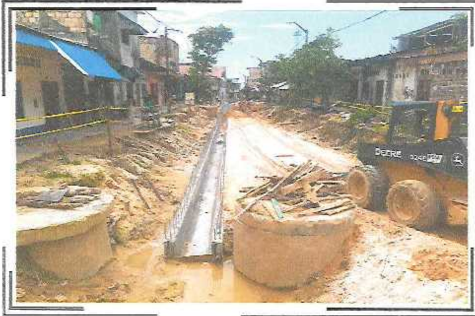
RELLENO DE MATERIAL A-3 EN P.S.J. QUIÑONES ENTRE P.S.J. MIAMI / CA. MARISCAL CACERES
