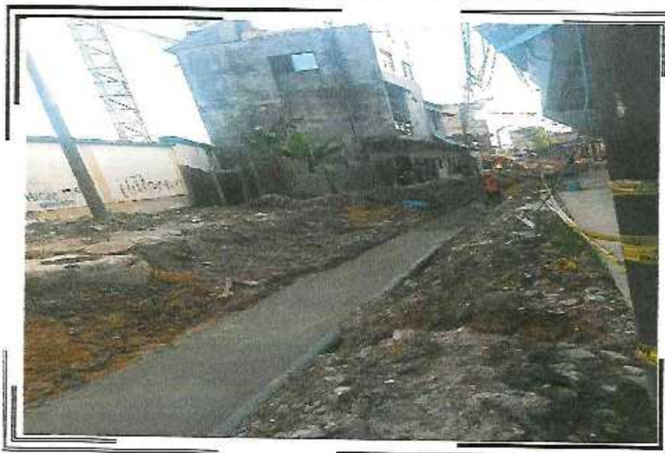
VACEADO DE SOLADO EN EL TRAMO PSJ. QUIÑONES ENTRE PSJ. MIAMI Y CA. MARISCAL CACERES
