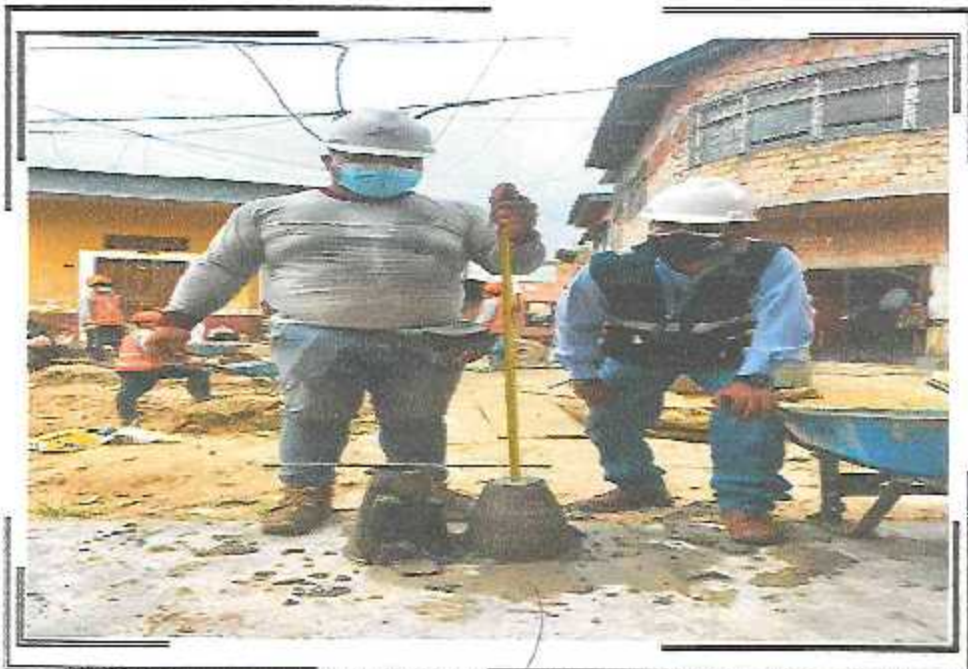
VERIFICACION DEL SLUMP CON LA SUPERVISION DEL VACADO DE LATERALES DEL CANAL MONTERO FIC-210925CM2
