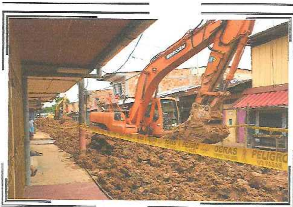
MOVIMIENTO DE TIERRA CON MAQUINARIA A NIVEL DE SOBREEXCAVACION EN EL PSJ GONZALES VIGIL.
