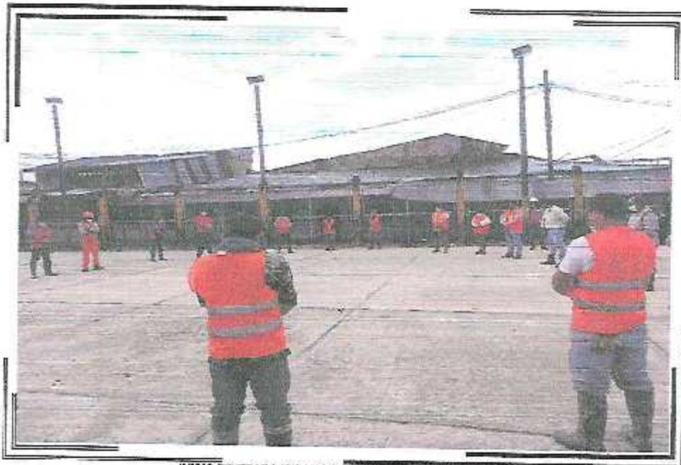
INICIO DE TRABAJOS MEDIANTE CHARLA DE SEGURIDAD
