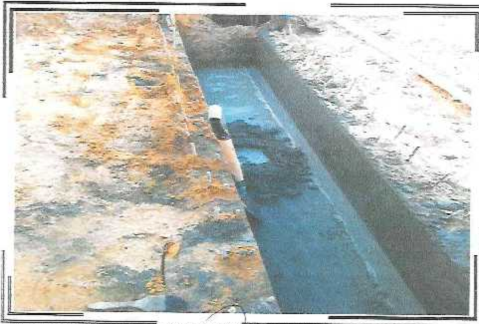
ENLUCIDO DEL CANAL INTERIOR DEL CANAL DE 0.80 X 0.80 DEL PSJ QUIÑONES TRAMO I DESDE LA CALLE 2 DE MAYO HASTA EL PSJ MIAMI
