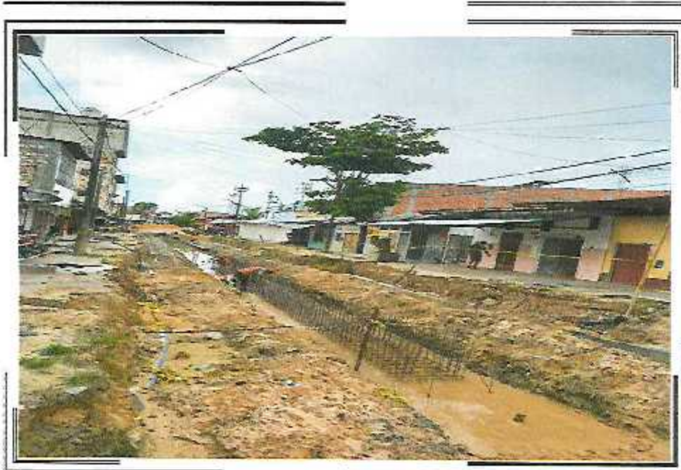
VACEADO DE LOSA DE FONDO EN CANAL DE 0.50 X 0.50 M EN EL TRAMO CA. QUIÑONES ENTRE CA. ABTAO Y CA. DOS DE MAYO
