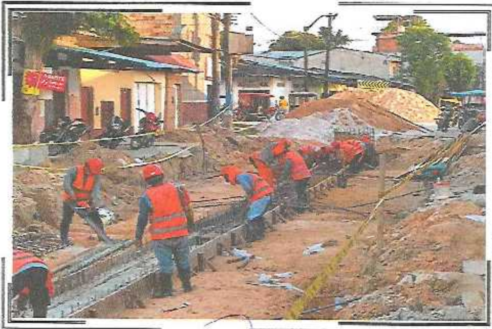
COLOCACION DE MALLA DE LOSA SUPERIOR DEL CANAL DE 0.50X0.50 DEL PSJ. QUIÑONES TRAMO II
