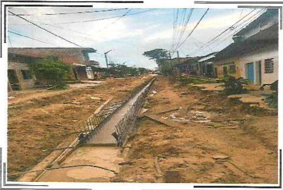
VACEADO DE LOSA DE FONDO CON MORTERO ARMADO F'c=210KG/CM2 EN EL TRAMO DE PSJ. QUIÑONES ENTRE CA. DOS DE MAYO Y PSJ. MIAMI
