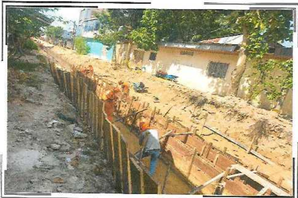
ENCOFRADO DE PARED DE CANAL DE 0.60 X 0.60M EN LA CA. QUIÑONES ENTRE AV. DEL EJERCITO Y CA. ABTAO
