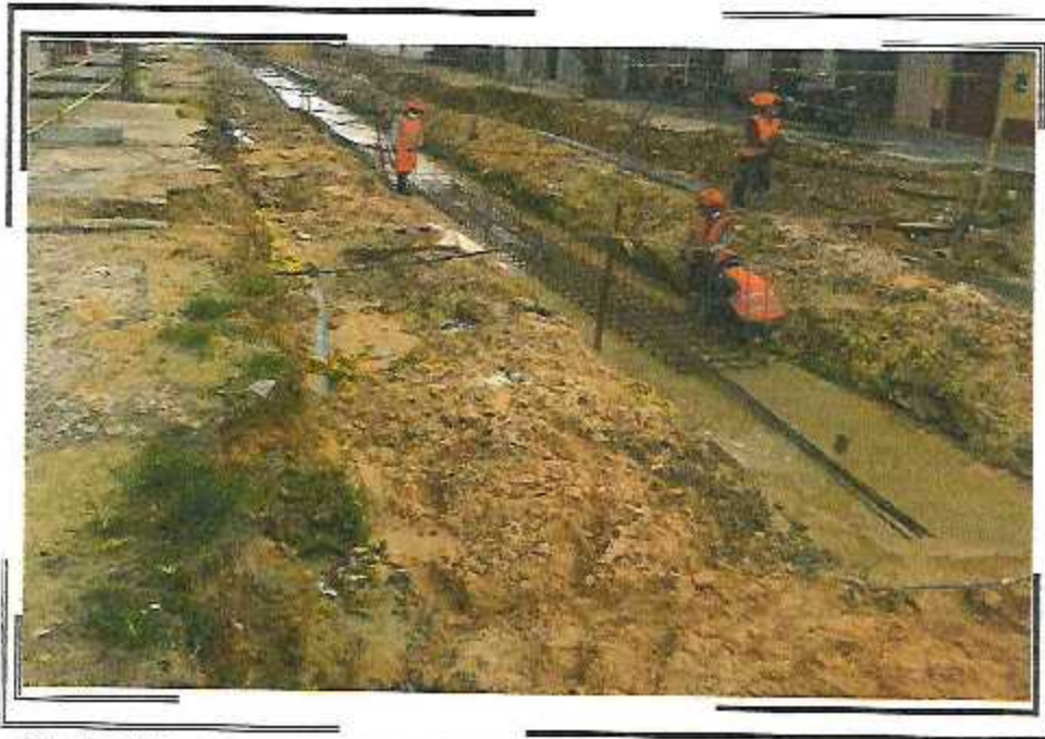
COLOCACION DE ACERO DE CANAL DE 0.50 X 0.50m EN LA CA. QUINONES ENTRE CA. ABTAO Y CA. DOS DE MAYO
