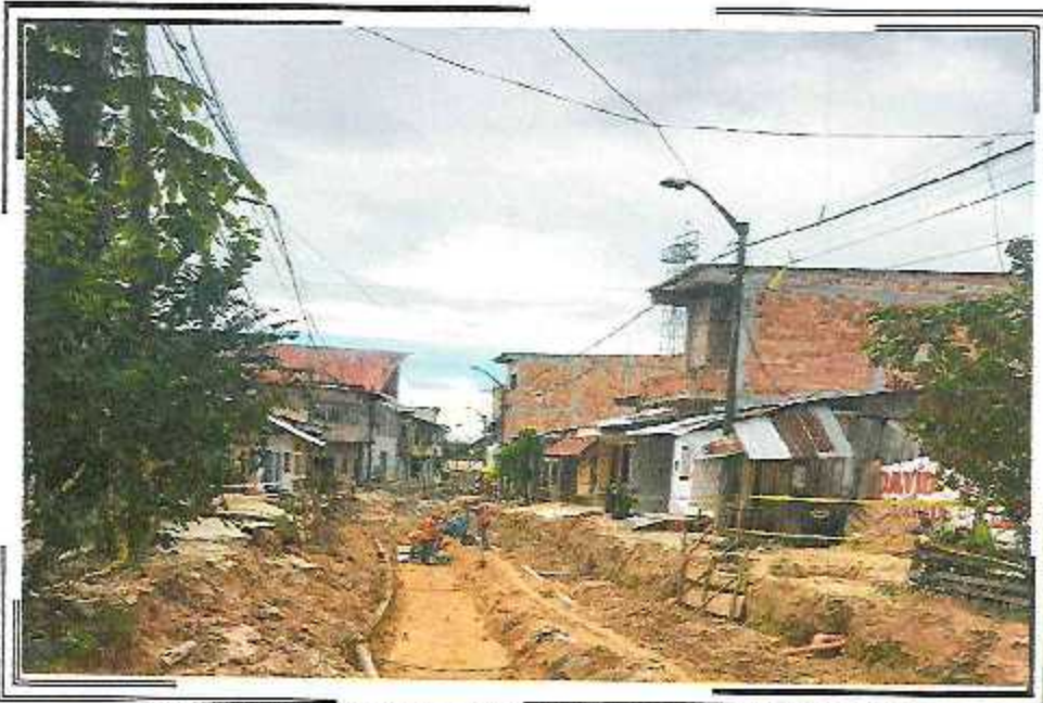
VACEADO DE SOLADO TRAMO PSJ. QUIÑONES ENTRE CA. DOS DE MAYO Y PSJ. MIAMI
