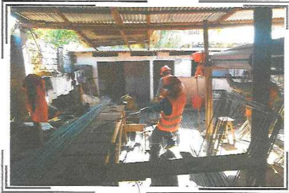
HABILITACION DE ACERO DE 12" Y 36" PARA CANALES DE P.S.J. QUIÑONES DE TRAMO I, II Y III
