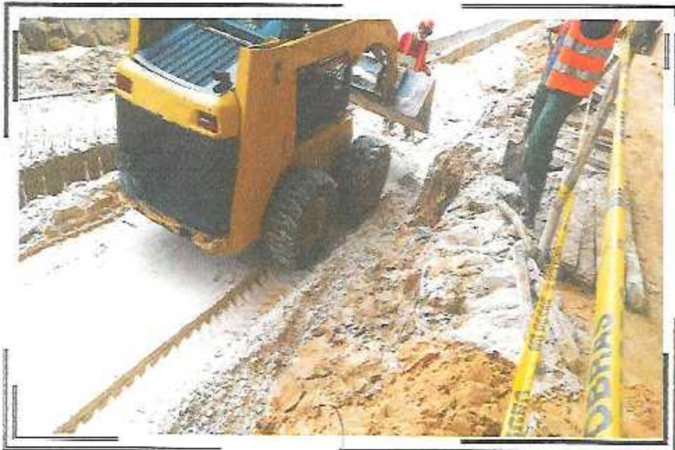
RELLENO DE MATERIAL A-3 EN EL PSL QUIÑONES TRAMO III
