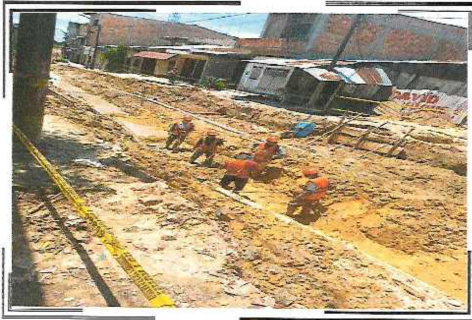
PERFILADO PARA VACEADO DE SOLADO TRAMO PSJ. QUIÑONES ENTRE CA. DOS DE MAYO Y PSJ. MIAMI
