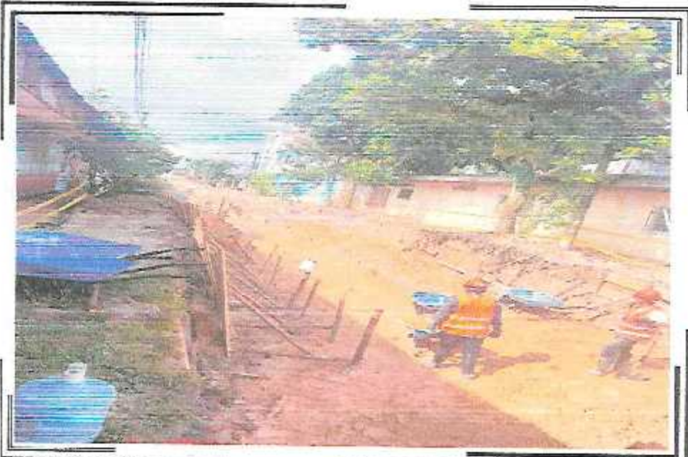
COLOCACION DE CAÑA DE ARENA CON MATERIAL DE PRESTAMO A-3 PARA CANAL PROYECTADO EN EL TRAMO DE CA. QUIÑONES ENTRE CA. DOS DE MAYO / AV. DEL EJERCITO
