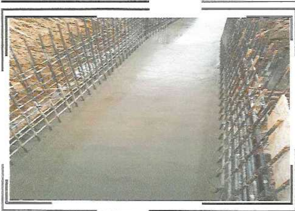
VACEO DE LOSA DEL CANAL DE 1.00X1.00 DEL PSJ. QUIÑONES TRAMO I
