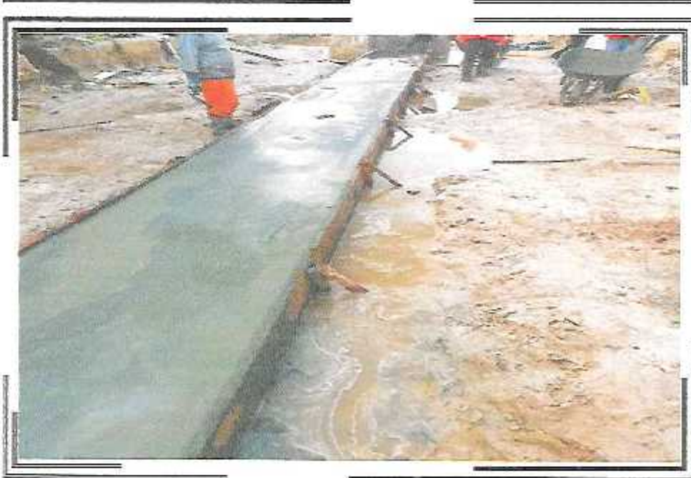
VACEADO DE LOSA SUPERIOR DEL CANAL DE 0.80X0.60 DEL P.S.I QUIÑONES TRAMO III
