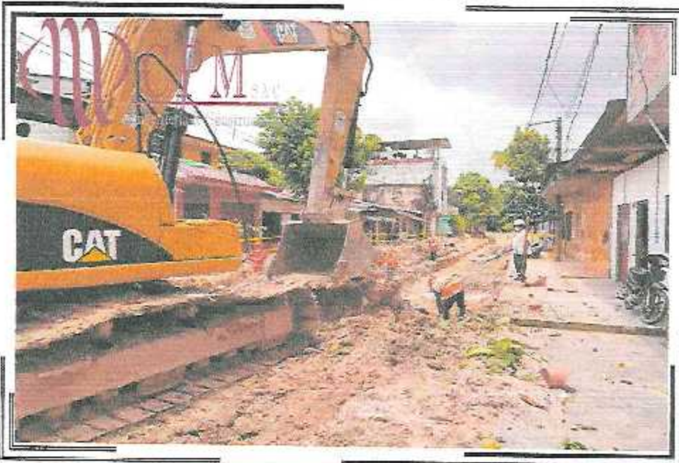
SE CONTINUA CORTE DE TERRENO A NIVEL DE SUBRASANTE CON MAQUINARIA CALLE QUINONES ENTRE AV. DEL EJERCITO / CA. ABTAO
