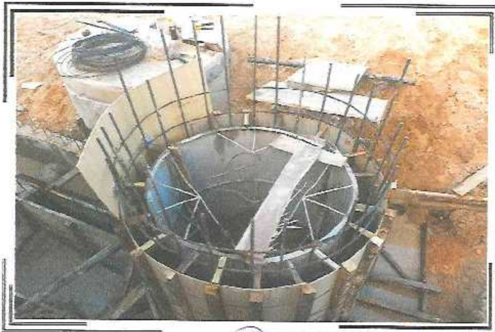
ENCOFRADO DE FUZON DE ARRANQUE DEL PSJ. QUIRIONES TRAMO I ENTRE LA CALLE 2 DE MAYO Y PSJ. MIAMI
