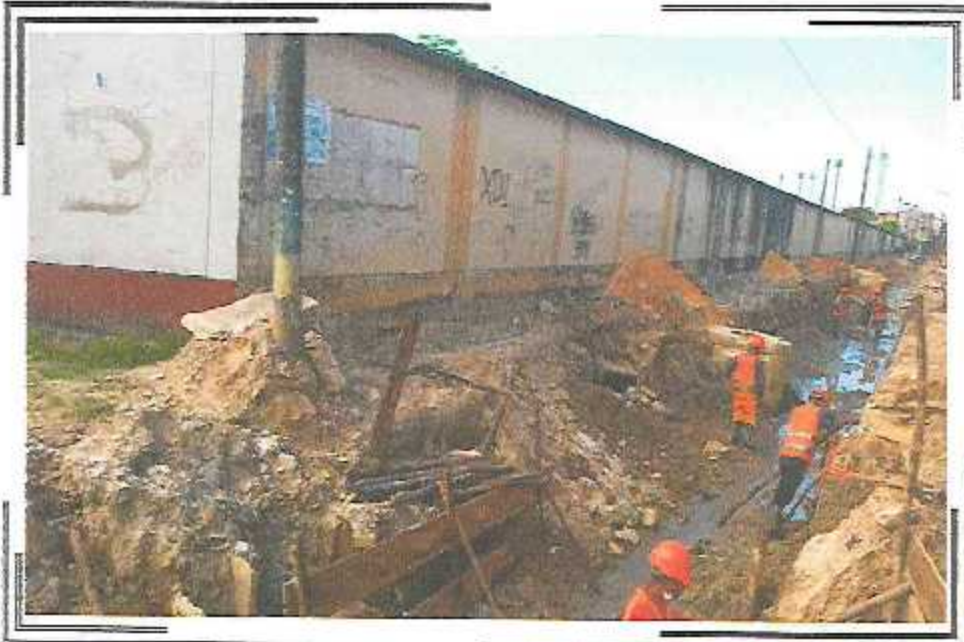
PERFILAMIENTO DEL PSJ QUIÑONES TRAMO I PARA EMPALMAR CON LA AV. CACERES
