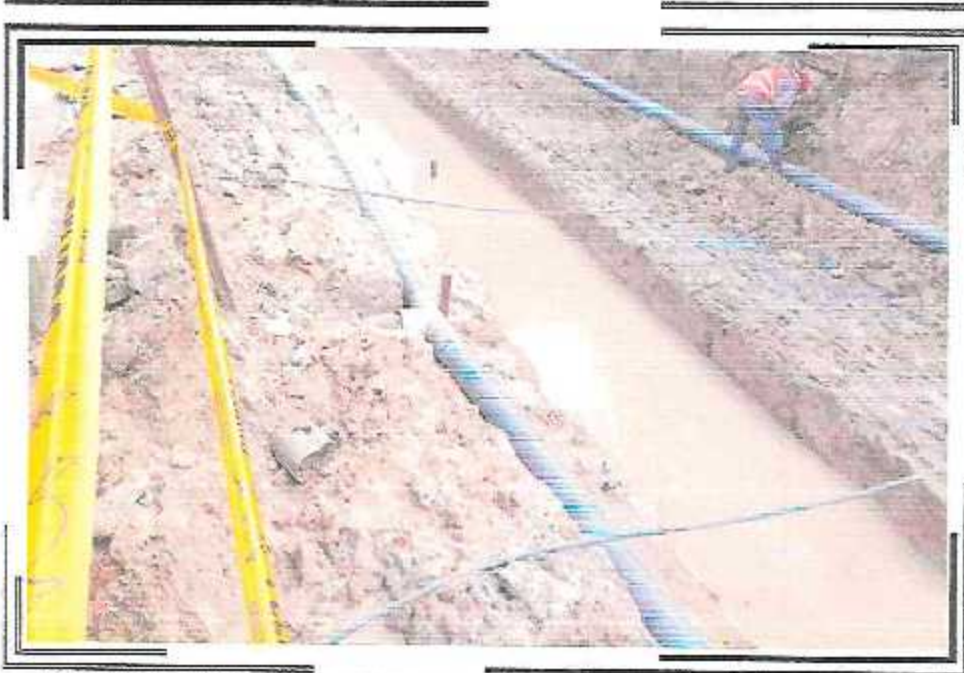
COLOCACION DE AUXILIARES EN EL TRAMO DE CA. QUIÑONES ENTRE CA. DOS DE MAYO / AV. DEL EJERCITO
