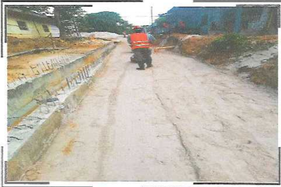
COMPACTACION DEL RELLENO DEL PSJ. QUIÑONES TRAMO III
