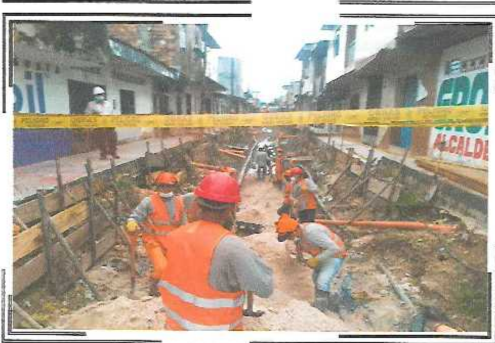
VACEADO DE SOLADO DEL PSJ. GONZALES VIGIL C/ AV. EJERCITO
